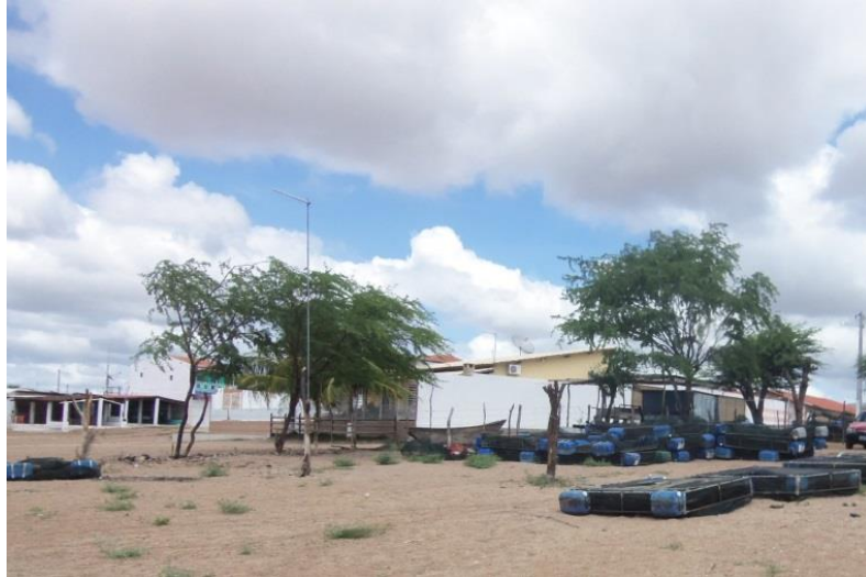
Foto 14: construções em APP do açude.
