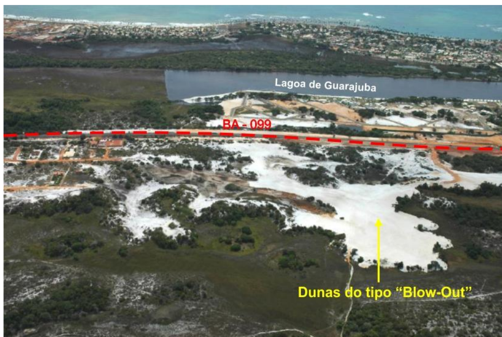
Figura 06 – A Rodovia BA-099 cortando as Dunas do tipo “Blow-Out” nas mediações da localidade de Guarajuba.
